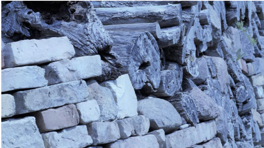
Ein „Nistparadies“ der Extraklasse ist diese Trockenmauer aus Holz und Stein im Naturschutzzentrum Ökowerk in Berlin - Charlottenburg
